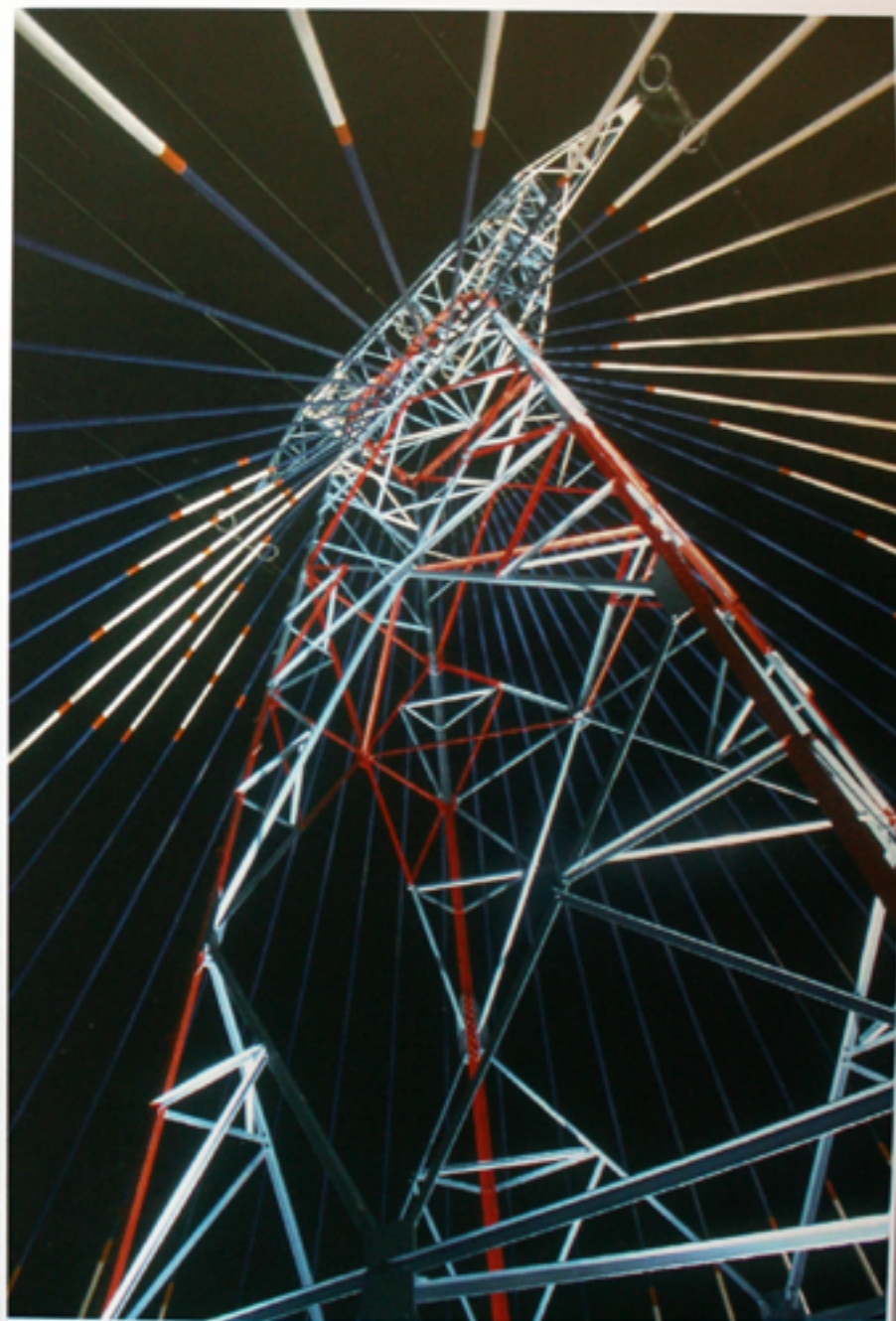
Ivorat-pylon n0 11 Amneville, France 28 / 15 / 15 m, стоманени кабели върху електрически стълб Ivorat-pylon n0 11 Amneville, France 28 / 15 / 15 m, steel cables on electricity pole
